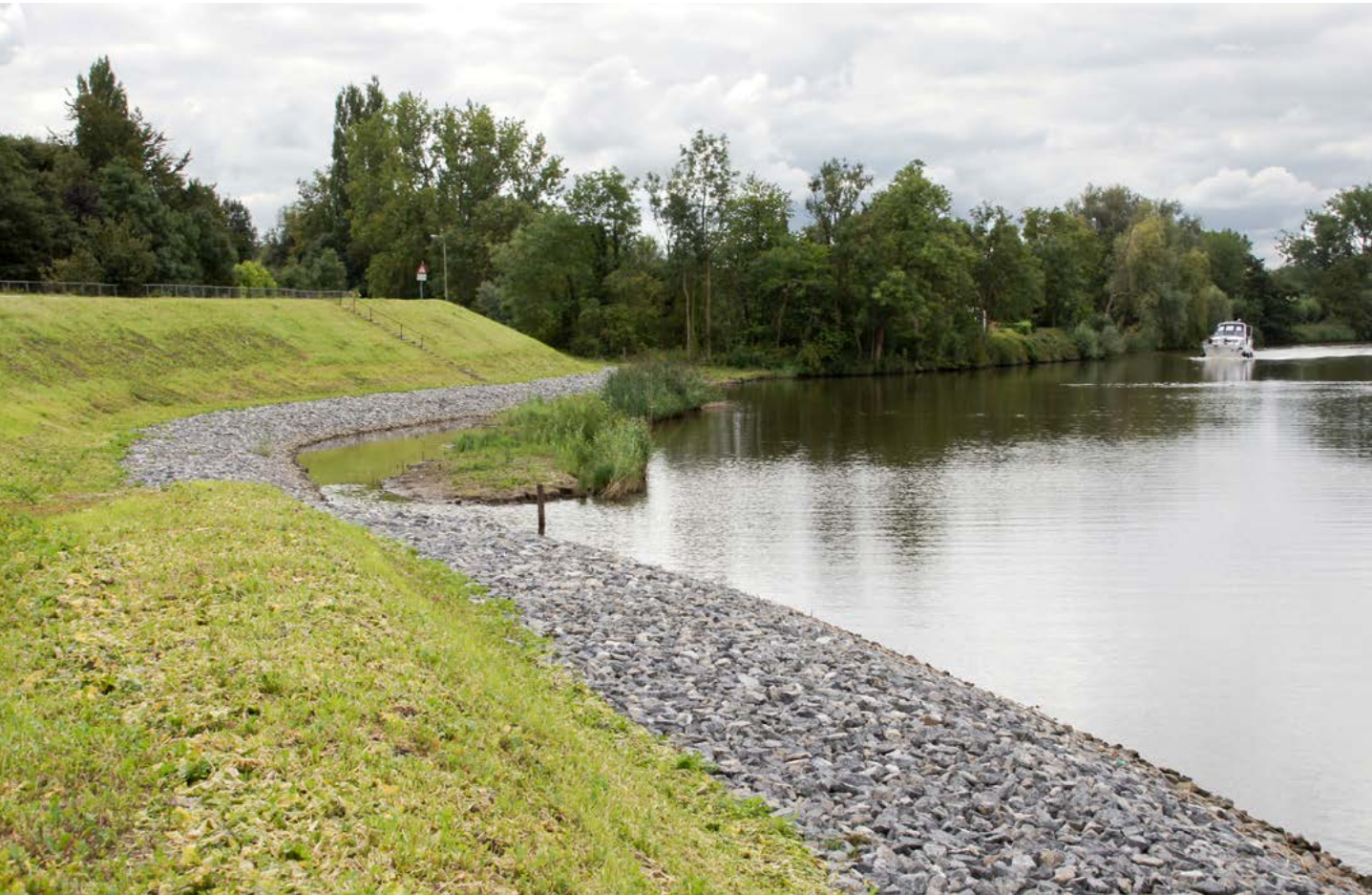
Dijkverbetering Diefdijklinie, Rivierenland.
