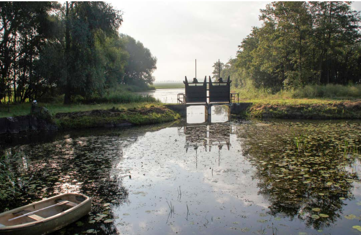
Herstel inundatiecomplex Mansveld, Poederroijen.
