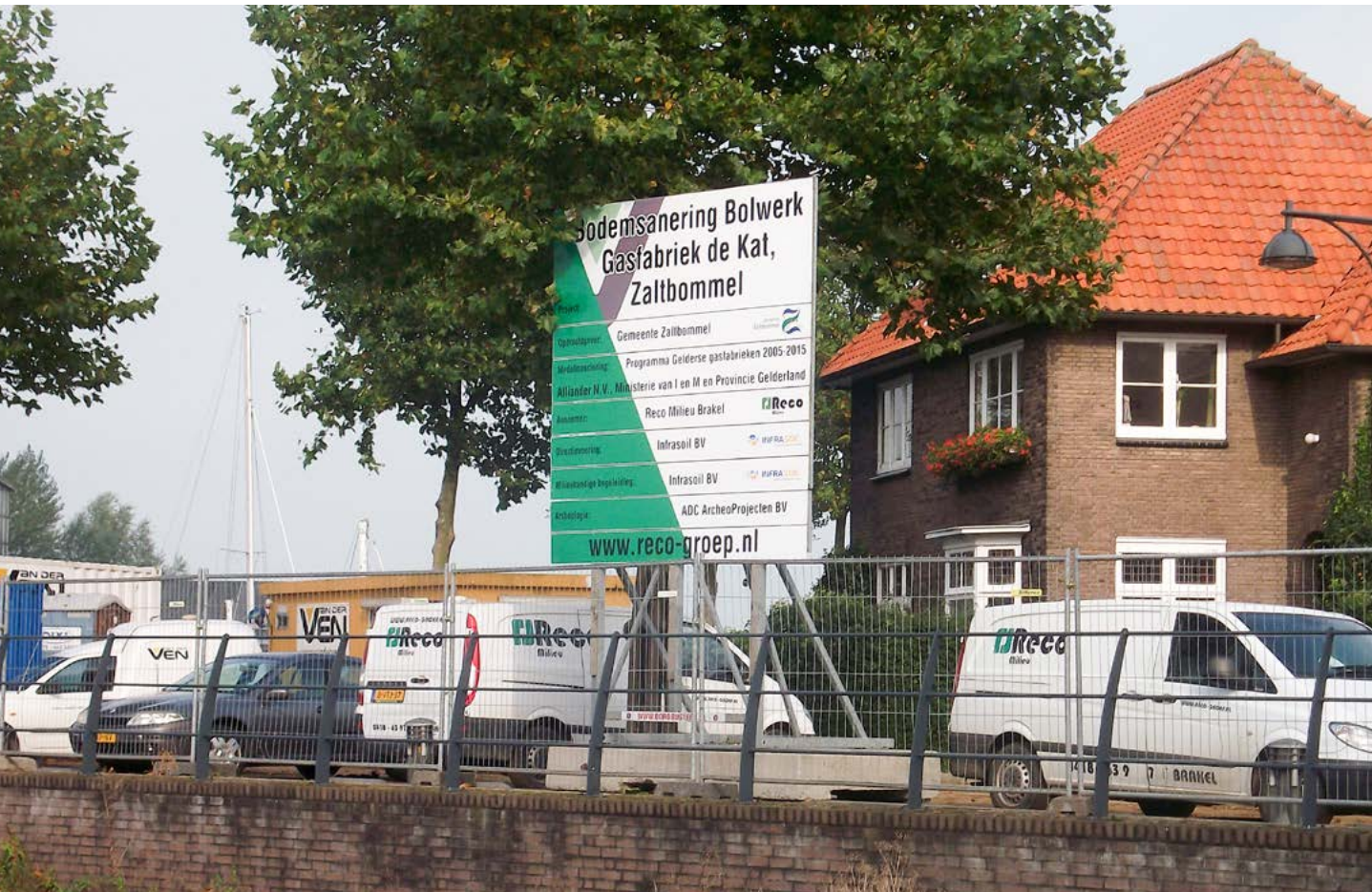
Sanering oude gasfabriek aan Bolwerk de Kat, Zaltbommel.
