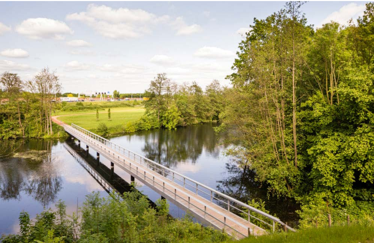
Brug, coupure en loods, Fort bij Vechten. Nieuwe Hollandse Waterlinie.
